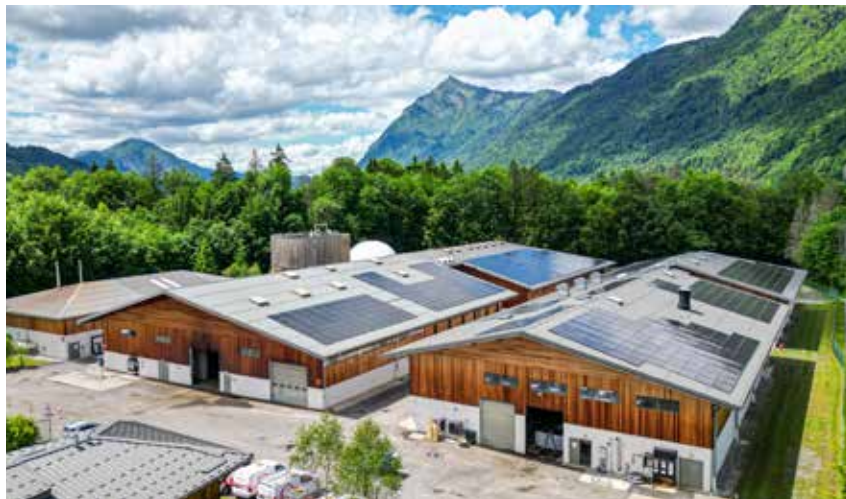
Station d'épuration à Morillon, gérée par le Syndicat intercommunal des Montagnes du Giffre (SIMG) jusqu'au 31 décembre 2025
