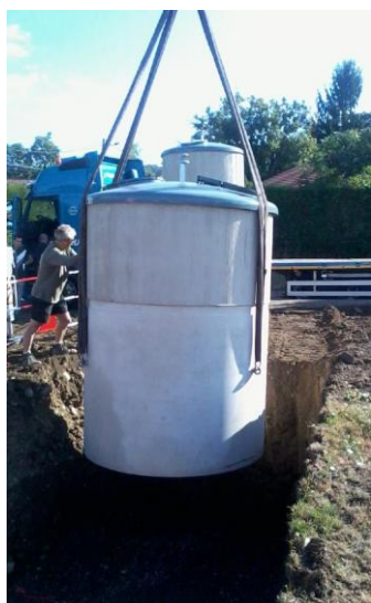
Travaux d'installation d'un conteneur semi-enterré
