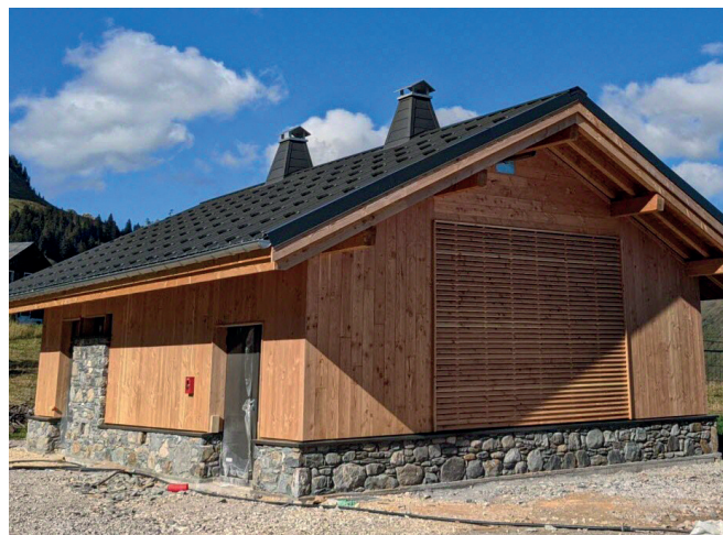
Construite en 2022, l'usine d'ultrafiltration située au Praz de Lys (secteur des Molliettes) permet le traitement de l'eau avant distribution
