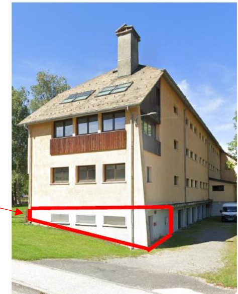
Emplacement de la chaufferie du groupe scolaire à réhabiliter
