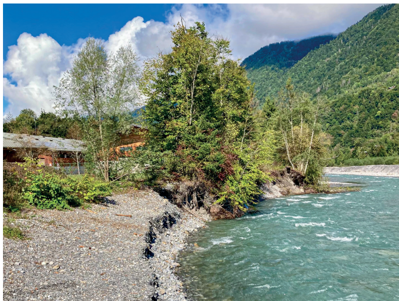
La berge du Giffre (en rive gauche), au droit de la station d'épuration à Morillon
