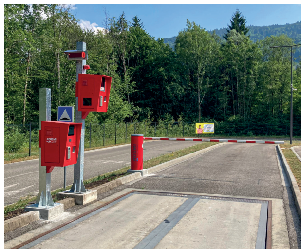
Pont bascule (pour la première et seconde pesée), avec le lecteur de badge
