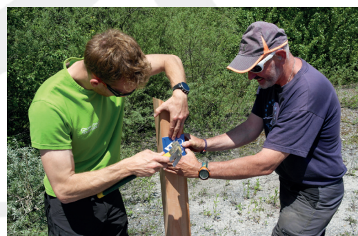
Les agents du service "sentiers" à pied d'oeuvre depuis plusieurs semaines pour aménager et baliser les parcours
